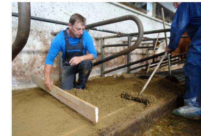
Perfekt mit Schlamm-sand verfüllt und abgezogen
