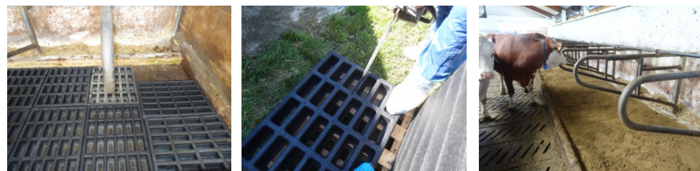
Sandbettwaben können zum Einpassen am Liegebuchtenende gut mit der Motorsäge zugeschnitten werden
