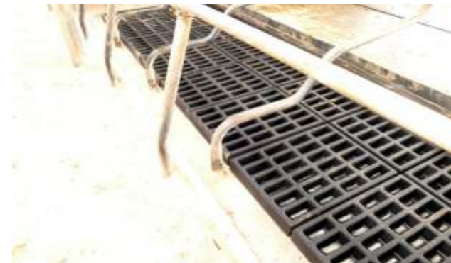
Die Waben werden schwimmend eingelegt
