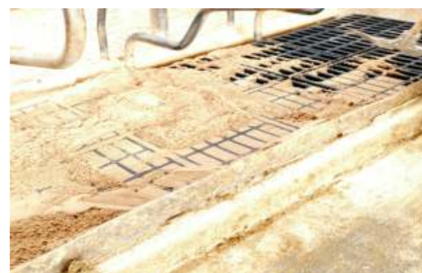
Abziehen, festtreten, überfüllen - fertig
